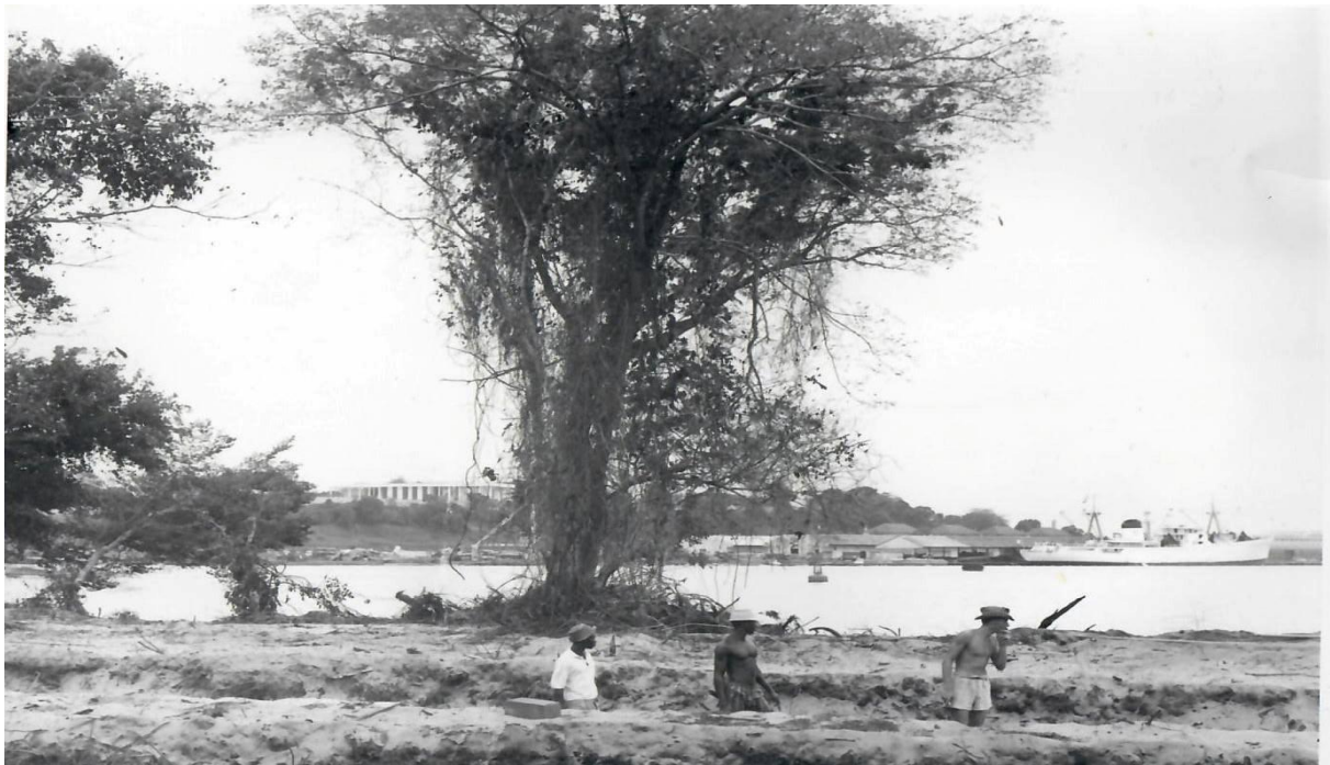
Jeudi 25 octobre 1962. Construction de la nouvelle Base de la Marine Nationale ivoirienne, à Lokodjro. En face, derrière le Quai des Bananiers, se trouve en hauteur le Palais de la Présidence de la République au Plateau.
