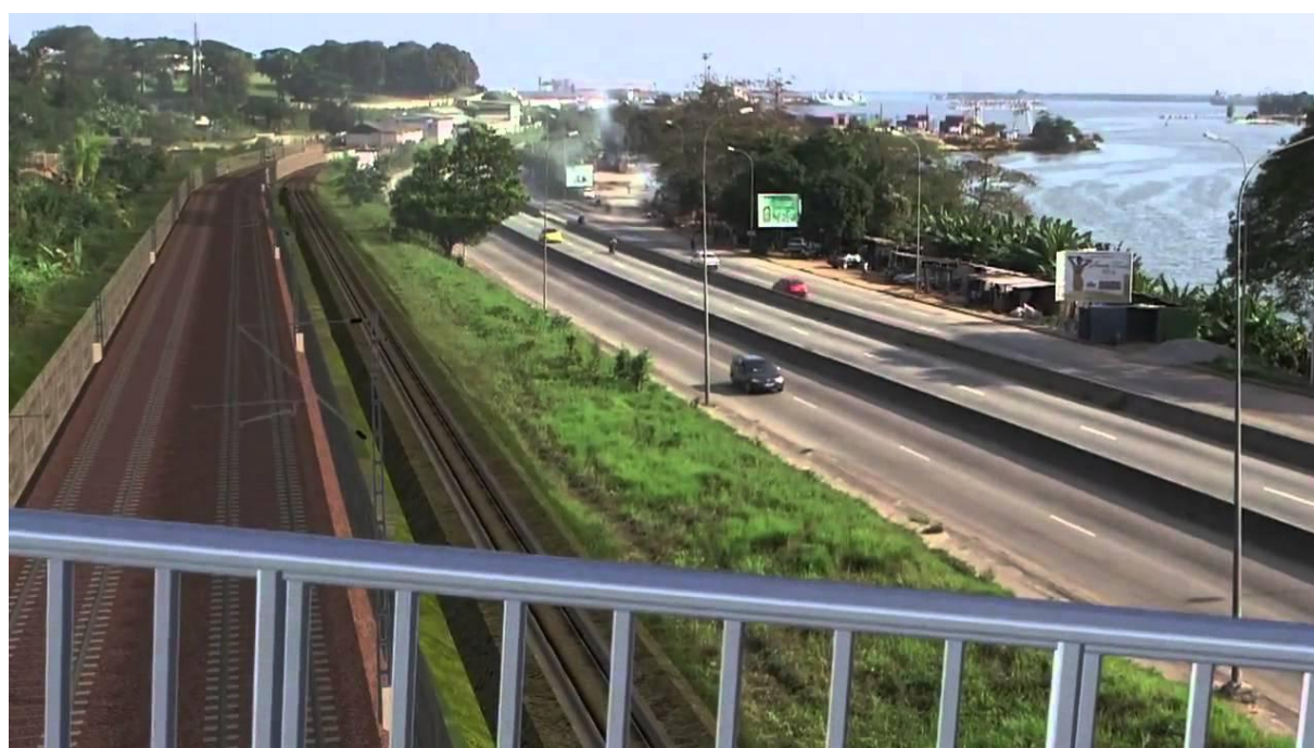
Agrandissement des voies de chemin de fer existantes
