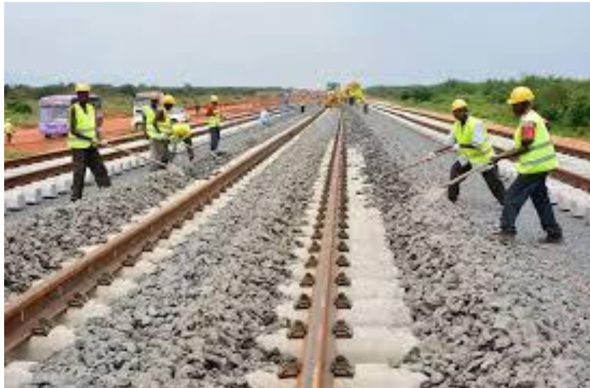
Réhabilitation et rénovation des voies de chemin de fer existantes
