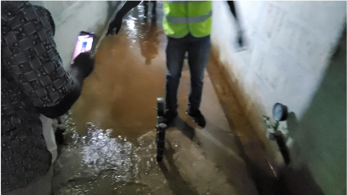
Visite dans les galeries du barrage
