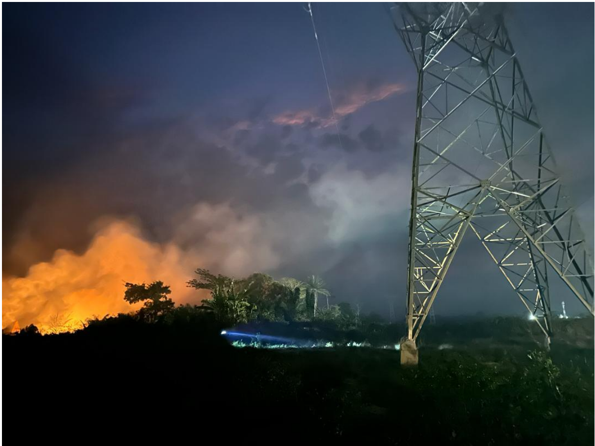
Départ de feux non loin du barrage mais vite maîtrisée
