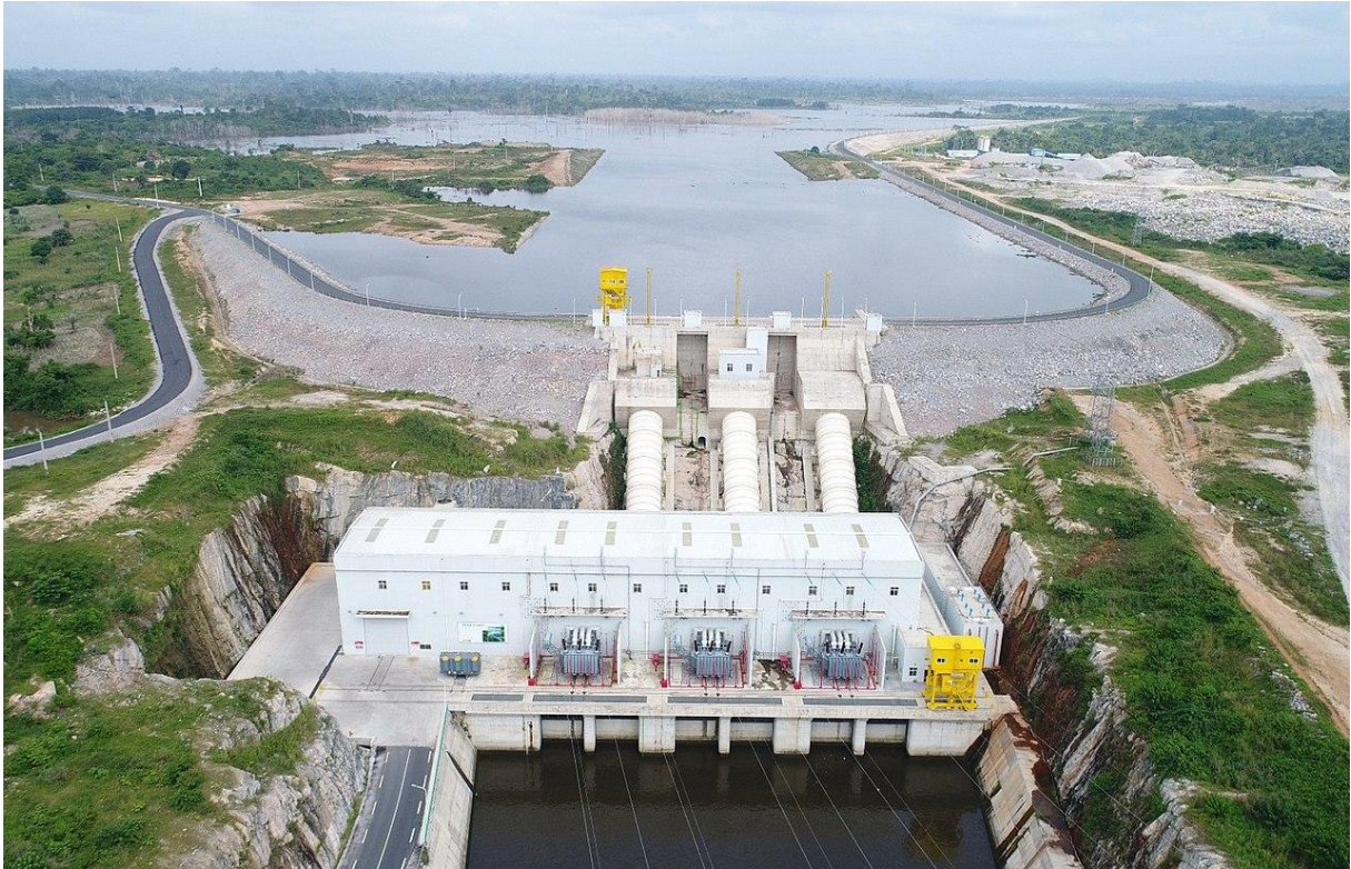
Une vue du barrage de Soubré
