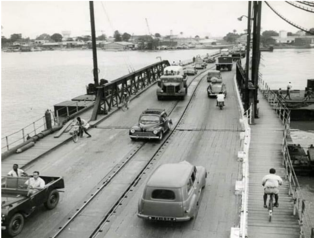
Le pont flottant avec ses rails en plein centre
