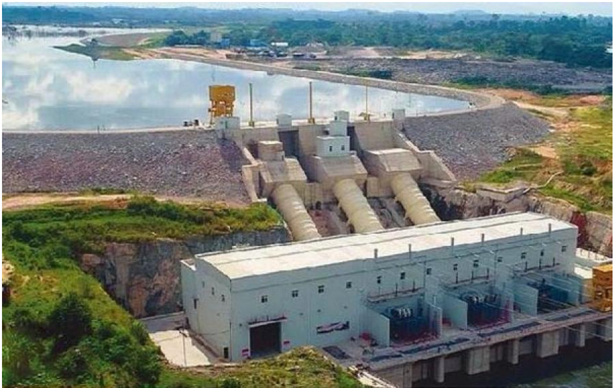
Barrage de Taabo
