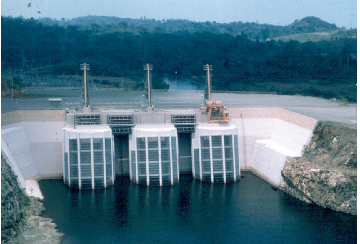
Centrale hydroélectrique de Kossou
